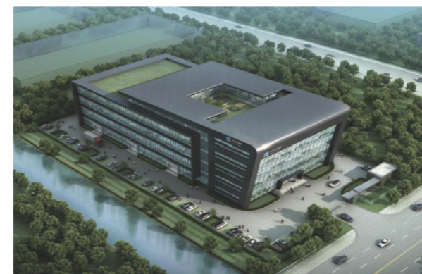
▪ 上海市工厂 Shanghai Factory
